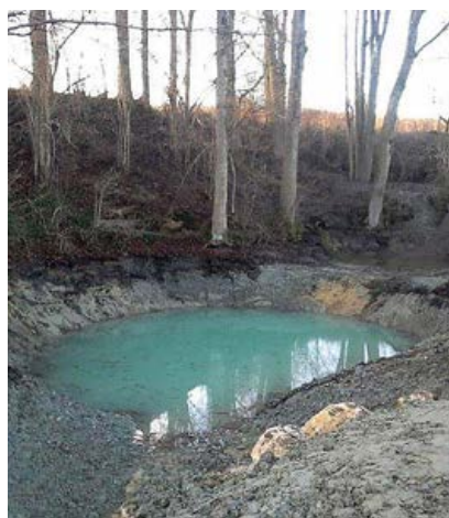
Sanierung des Löschteiches in Wolfgangstein/Grub
